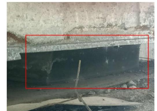
图 3-14: 西洋 2 号大桥（上行）ZZ-6-6-5 支座：纵向剪切；数量：1 个，角度：10°。
