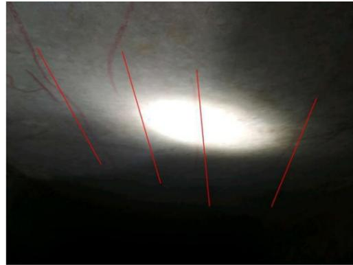
图 3-3: 虎尾大桥（上行）8DINB 箱梁：距 8 号墩 33m 处，距右侧 2m 处，梁顶纵向裂缝；数量：4 条，长度：0.7m，宽度：0.13mm。
