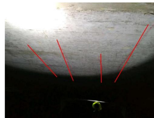
图 3-1：后溪坂 1 号大桥（上行）4D1NB 箱梁：距 3 号墩 42.7m 处，距右侧 2m 处，梁顶纵向裂缝；数量：11 条，长度：2m，宽度：0.12mm。
