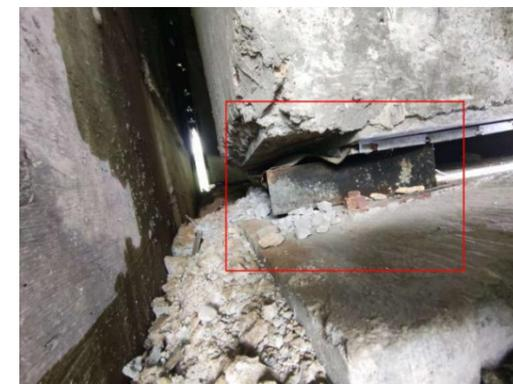
图 3-13: 沙溪大桥（上行）ZZ-9-8-2 支座：位置串动；数量：1 个，位移：0.15m。
