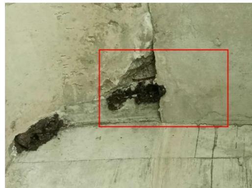
图 3-8: 西洋 2 号大桥（上行）3-4T 梁：距 3 号墩 0m 处，右翼缘板破损露筋；数量：1 处，长度：0.4m，宽度：0.35m。
