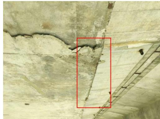
图 3-5: 后溪坂 1 号大桥（下行）4DIB 箱梁：距 3 号墩 50m 处，距左侧 0m 处，梁底露筋；数量：1 处，长度：1.5m。
