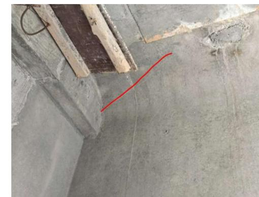
图 3-2：后溪坂 1 号大桥（下行）6-5T 梁：距 5 号墩 0m 处，右翼缘板斜向裂缝；数量：1 条，长度：1m，宽度：0.1mm。
