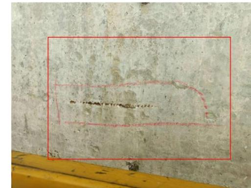
图 3-11: 虎尾大桥（上行）GR-6D 盖梁：距左侧 3m 起，小桩号面露筋；数量：1 处，长度：0.5m。
