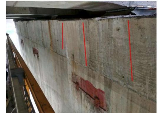
图 3-10: 沙溪大桥（上行）GL-5D 盖梁：距右侧 4m 处，小桩号面竖向裂缝；数量：10 条，长度：0.5m，宽度：0.12mm。
