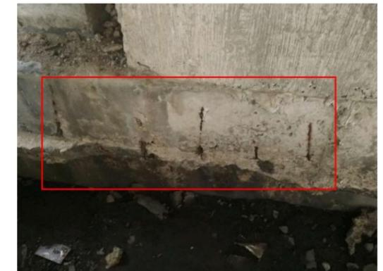
图 3-12: 虎尾大桥（下行）TS-11T 台身：距右侧 0m 处，前墙露筋；数量：4 处，长度：0.2m。
