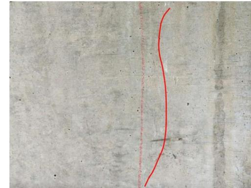
图 3-9: 后溪坂 1 号大桥（下行）GL-5D 盖梁：距左侧 1m 处，小桩号面竖向裂缝；数量：1 条，长度：1m，宽度：0.15mm。
