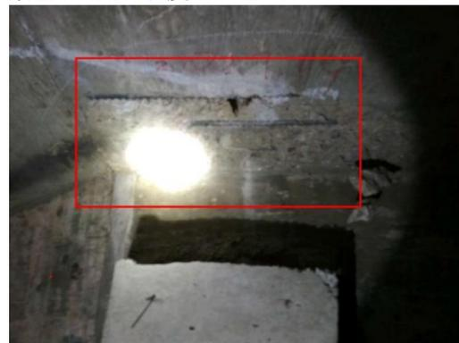
图 3-7: 沙溪大桥（上行）7DINB 箱梁：距 7 号墩 27m 处，距右侧 1.3m 处，梁顶破损露筋；数量：1 处，长度：0.3m，宽度：0.2m。
