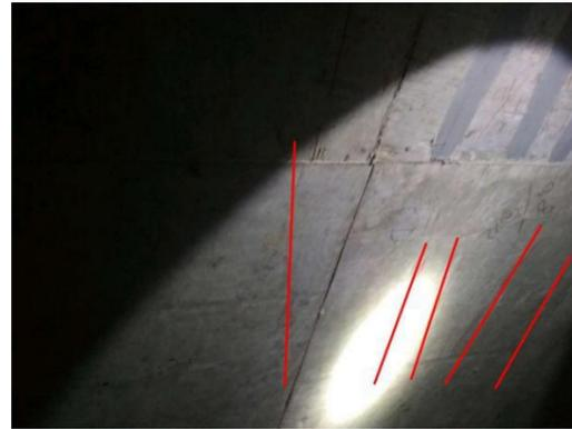
图 3-4: 沙溪大桥（上行）9DINB 箱梁：距 9 号墩 5.5m 处，距右侧 2.5m 处，梁顶纵向裂缝；数量：16 条，长度：0.7m，宽度：0.13mm。
