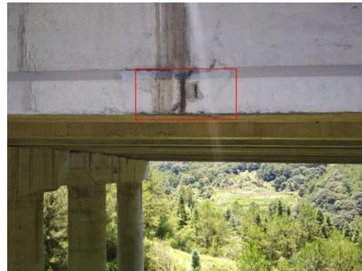
图 3-6: 虎尾大桥（上行）4-1T 梁：距 3 号墩 9m 处，马蹄右侧面露筋；数量：1 处，长度：0.15m。
